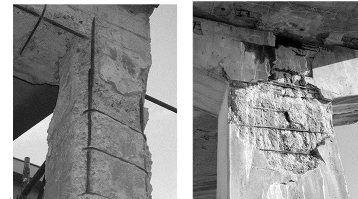
Рис. 5. Ослабление сечения элемента по бетону:
