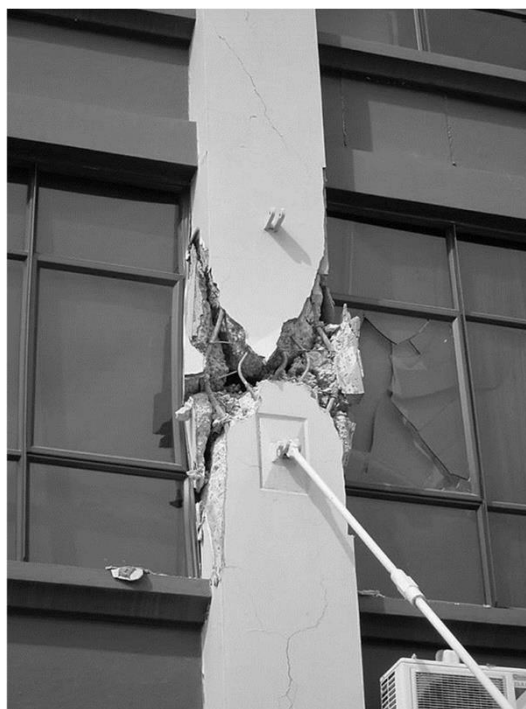
Рис. 4. Выпучивание сжатой жесткости», обеспечивает местную арматуры устойчивость продольных стержней арматуры колонн.
