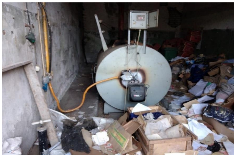
Рис. 3. Установка термического обезвреживания биологических отходов на ГБУ «Ветубой» на новом месте.
