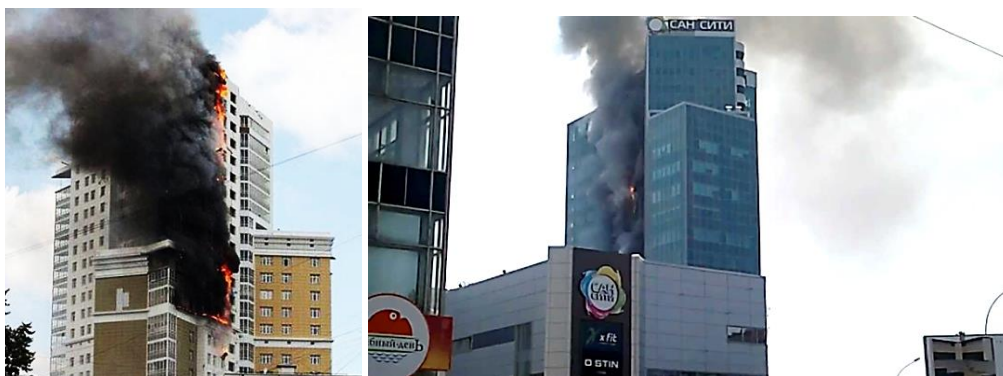
Рис. 3. а - высотное здание на улице Ивана Бабушкина (Москва) ( https://ru.fishki.net/picsw/082009/07/fire/006.jpg , дата обращения 12.09.2023); б - многофункциональный комплекс «Сан Сити» в Новосибирске ( https://i.ytimg.com/vi/AKil8lvsPIM/maxresdefault.jpg , дата обращения 12.09.2023)
