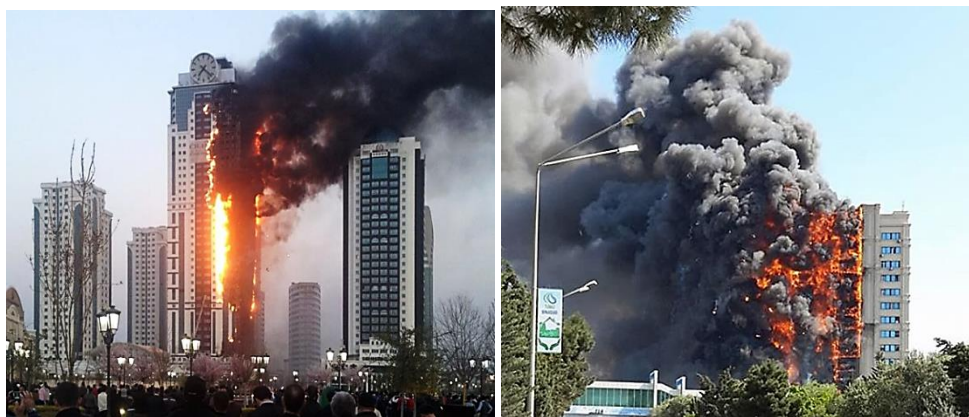
Рис. 4. а - многоэтажное здание комплекса «Грозный-Сити» в г. Грозном (Россия) ( http://crozspb.ru/upload/medialibrary/6c5/6c55bee068aebb30d5c6fd4cc2afdb3c.jpg , дата обращения 12.09.2023); б - пожар в 16-этажном жилом доме на проспекте Азадлыг в Баку (Азербайджан) ( https://cdn.tvc.ru/pictures/o/165/318.jpg , дата обращения 12.09.2023)
